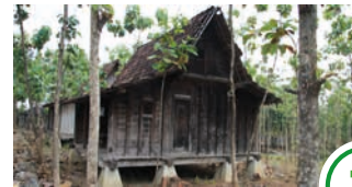
Abriss des Holzhauses
