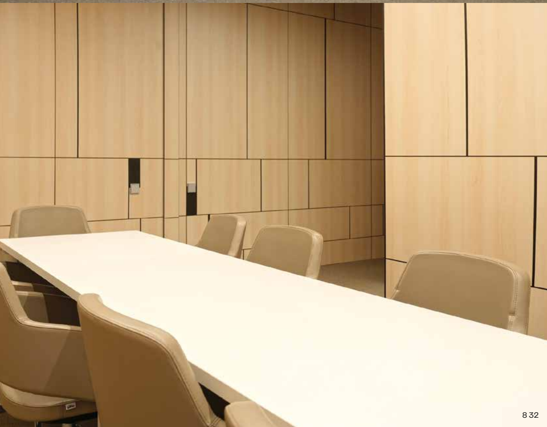
8 31 Wandverkleidung direkt geklebt 8 32 Wandverkleidung direkt geklebt
